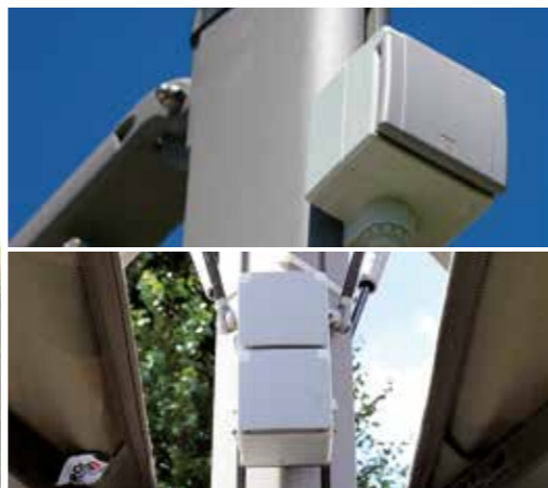
La prise double ou simple se fixe sur le mât.
